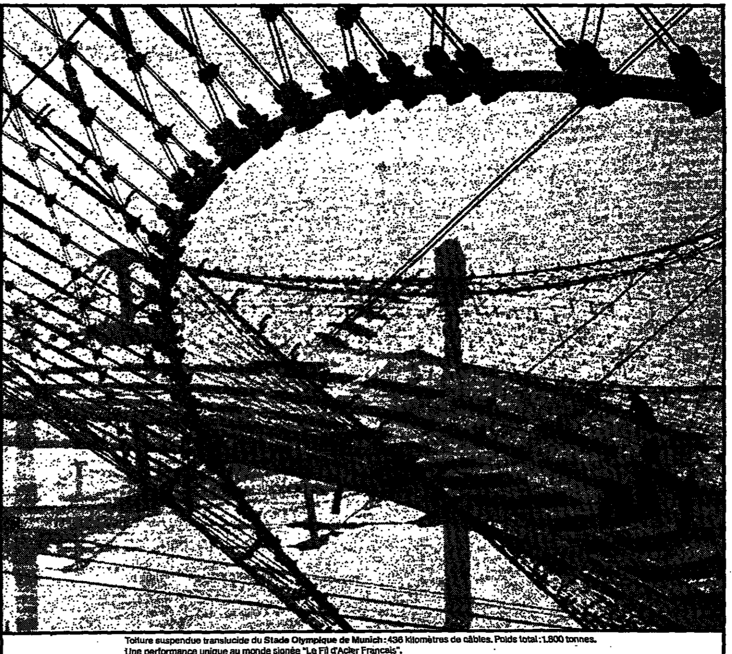
Tolure suspendue transalpine du Stade Olympique de Munich: 438 kilomètres de câbles. Poids total: 1.800 tonnes. Une performance unique au monde signée "Le Fil d'Acier Français".
